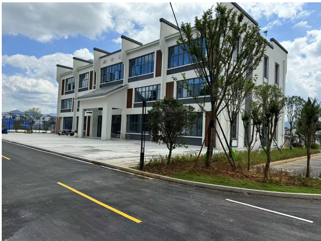
项目现状照片
